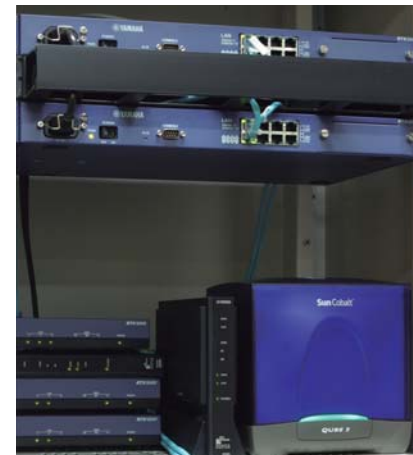
新出光フォーバル(アクセスセンター)に設置されたRTX2000、RTX1000とRT57i
