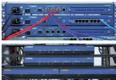
本社のシステム室に設置されたヤマハのルーター群。データと音声の安定した通信に貢献している。
