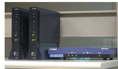
オレンジライフのマシン室に設置されているヤマハルーター「RT57i(左側)」と「RTX1000(右側)」
