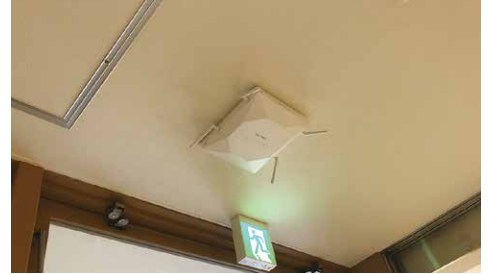
▲手稲ゆうゆうに設置された無線LANアクセスポイント
